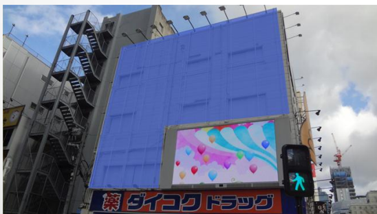
真下からは2階部分より4階建てまで約9mの高さ。
